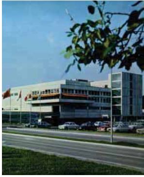
Migros Betriebszentrale, Dierikon 1971
